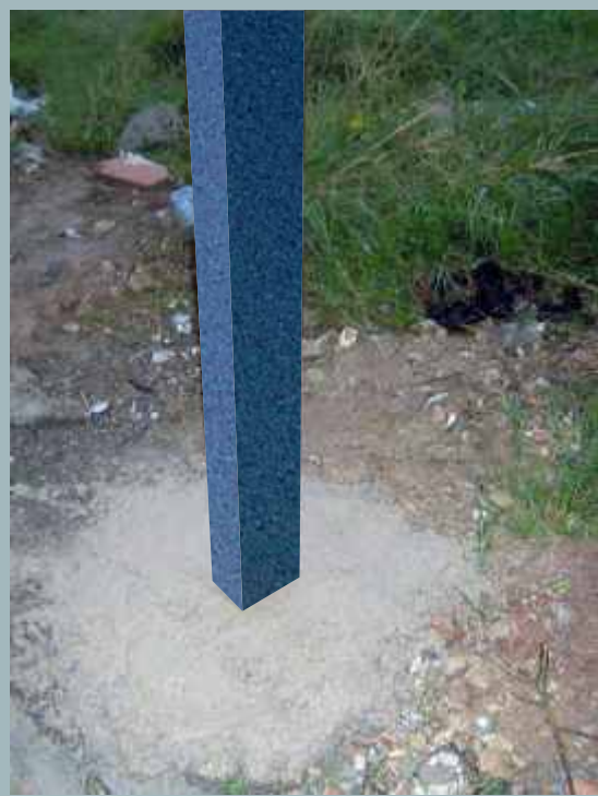
Vista de uno de los postes colocados
